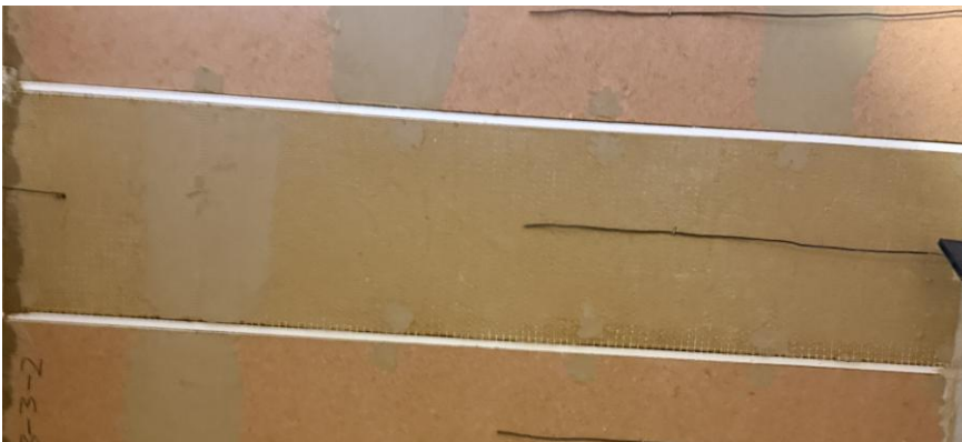
Abbildung 4 Horizontale Probekörper vor Prüfung Figure 4 Horizontal test specimen before testing
