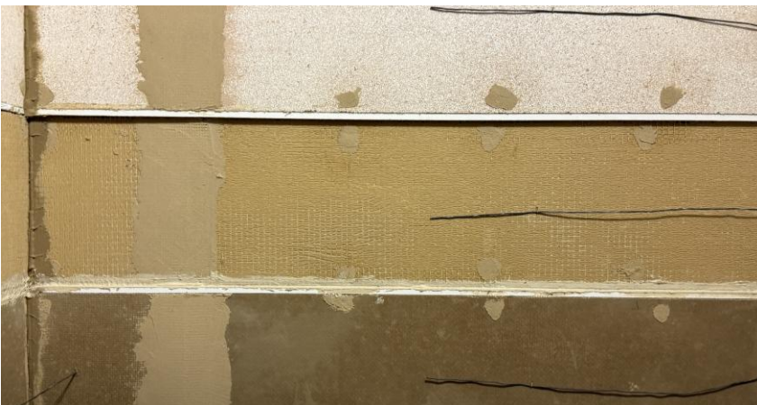
Abbildung 4 Horizontale Probekörper vor Prüfung Figure 4 Horizontal test specimen before testing
