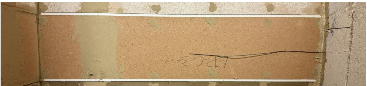
Abbildung 4 Horizontale Probekörper vor Prüfung Figure 4 Horizontal test specimen before testing
