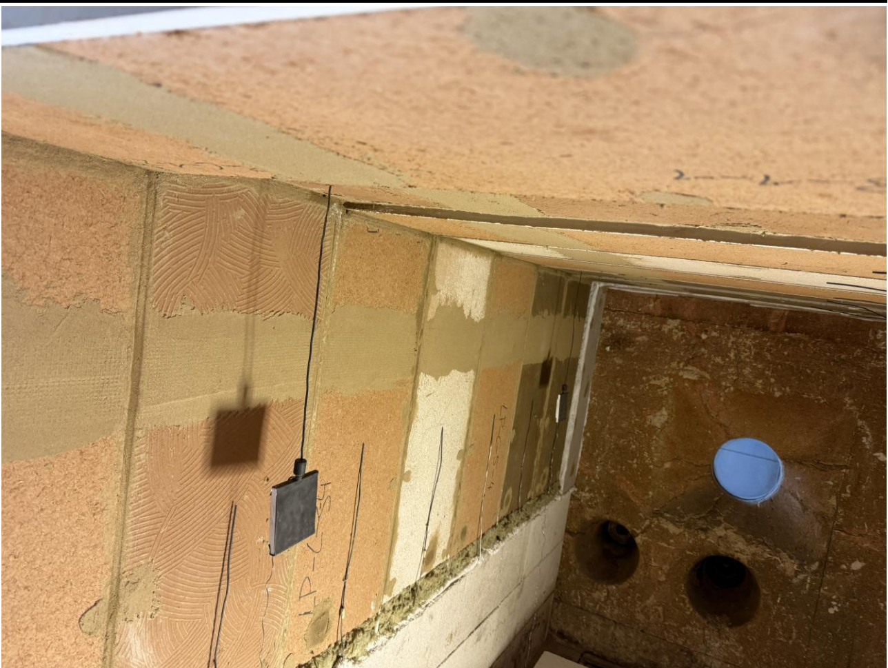
Abbildung 1 Brandraum vor Prüfung Figure 1 Furnace chamber before testing
