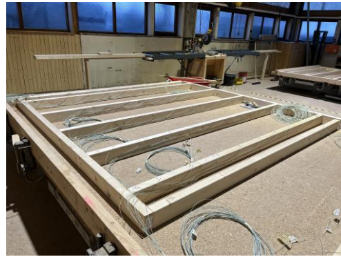
Herstellen und Instrumentieren Holztafelbaukonstruktion
