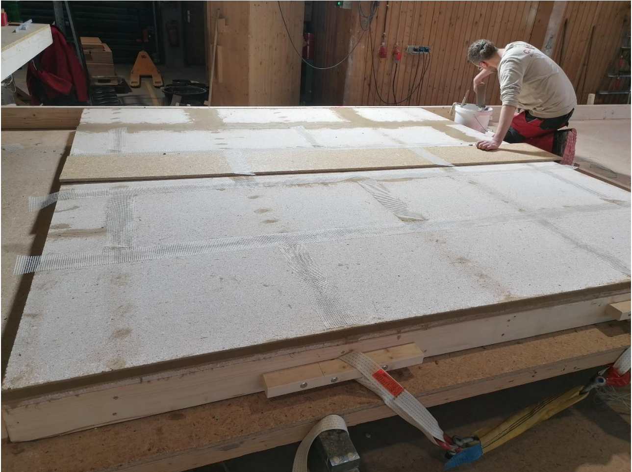
Bild 2 2. Plattenlage bei der Herstellung
